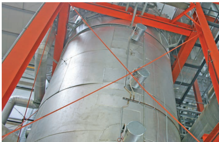
Czyszczenie wymienników ciepła (po prawej stronie NHK z osłonami dźwiękochłonnymi)
