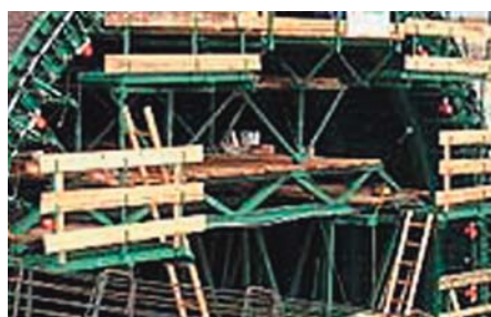
Oszalowanie tunelu
